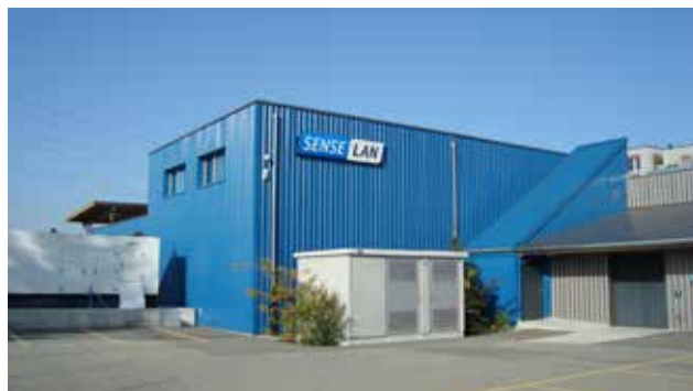
Das SenseLAN Data Center in Düdingen.
